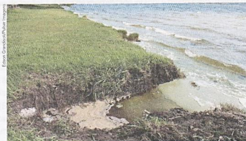
5.8 A falta de saneamento básico é um dos fatores de risco para muitas doenças. A foto mostra o despejo de esgoto sem tratamento em uma lagoa em Florianópolis (SC), 2016.
